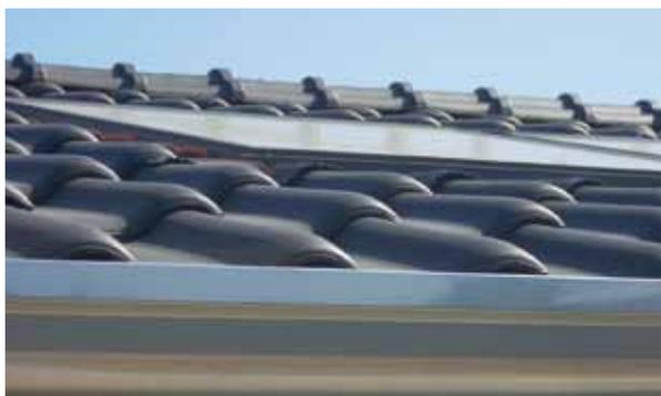
Il collettore solare VELUX risulta perfettamente integrato con la copertura. Nella foto sopra sono state utilizzate delle tegole aventi lo stesso colore del collettore VELUX.
