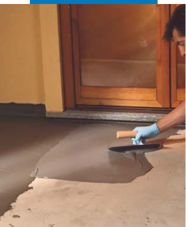
Impermeabilizzazione di terrazzo a spatola
