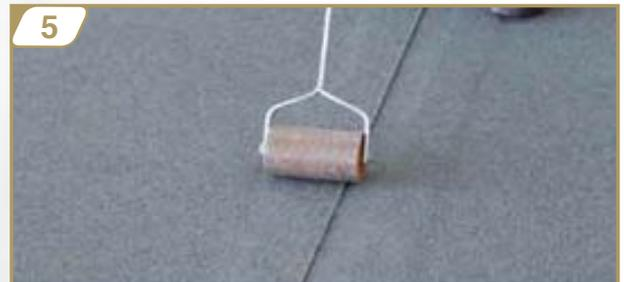
7. In caso di basse temperature (comunque superiori ai 5 °C), per aumentare l'adesione delle sovrapposizioni, è possibile riscaldare la parte superiore delle stesse con strumento ad aria calda (Leister) o con bruciatore a gas propano senza fiamma.
