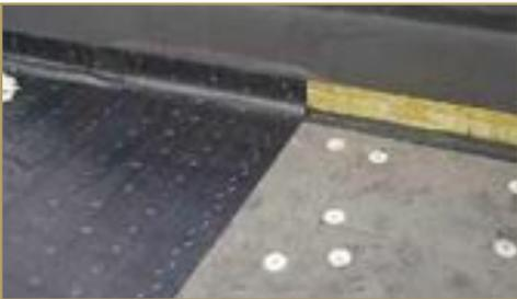
Le membrane autoadesive con tecnologia **ADESO**® possono essere impiegate su tutte le superfici da impermeabilizzare, a condizione che esse siano pulite, asciutte e prive di umidità. Un ottimo campo di utilizzo è al di sopra di pannelli isolanti sensibili alla fiamma (es. polistirene espanso o estruso, poliuretano). Sono tuttavia da evitare i pannelli fibrosi o particolarmente polverosi.
