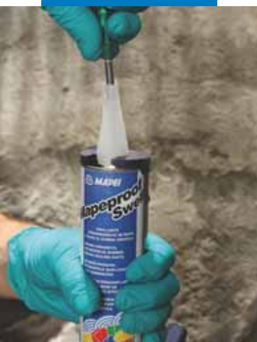
Foratura della membrana di protezione di Mapeproof Swell
