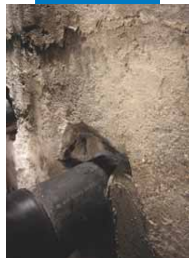
Confinamento di Mapeproof Swell con Mapegrout T40
