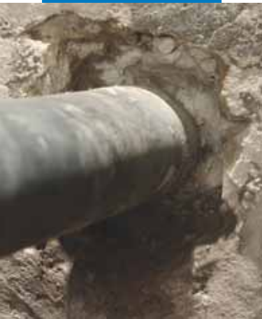
Demolizione della struttura intorno al tubo
