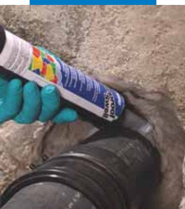
Applicazione di Mapeproof Swell intorno al tubo
