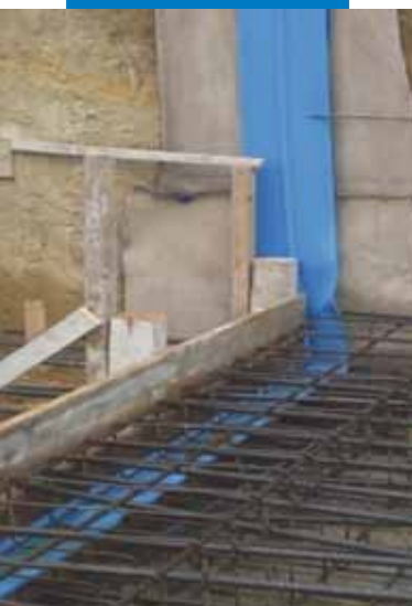
Sigillatura di giunto strutturale in parete verticale
