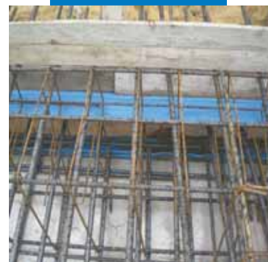
Sigillatura di giunto strutturale in platea
