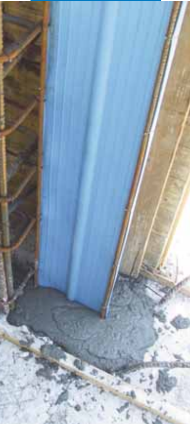
Schema tecnico del posizionamento di Idrostop PVC BE
