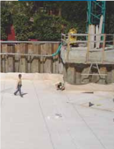
Impermeabilizzazione di struttura interrata contro palancole
