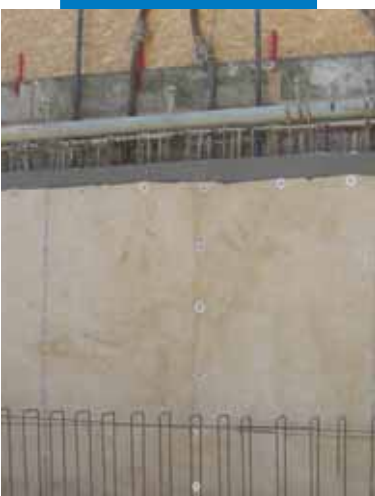
Impermeabilizzazione di pareti verticali contro micropali
