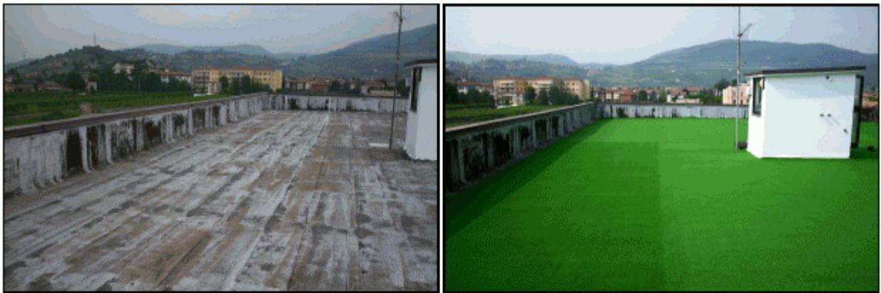
Ecco la trasformazione di un terrazzo prima ricoperto dalla sola guaina impermeabilizzante
